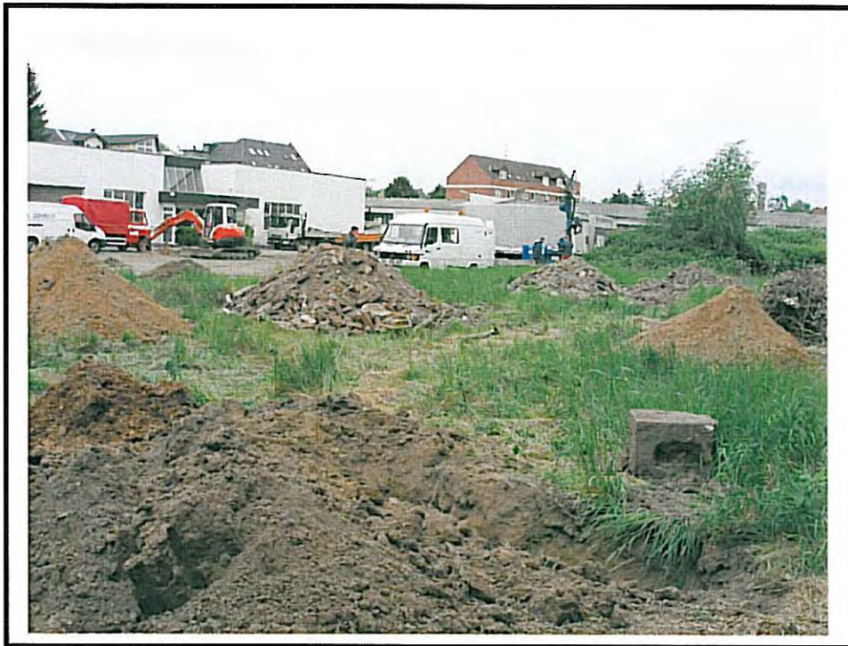
Bild 10: Übersicht Teilfläche MP 2, Blickrichtung Nordwest
