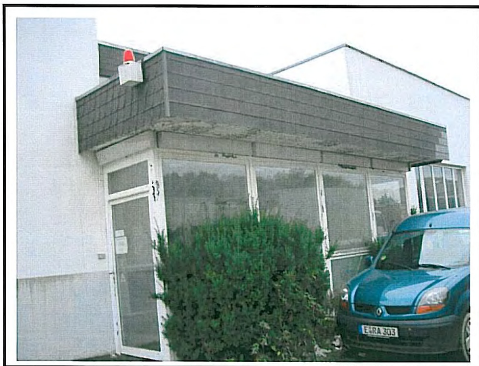
Bild 10: Front Bürogebäude (Vorbau mit Verblendung )
