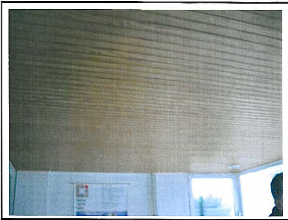
Bild 11: Innenansicht Bürovorbau, Holzvertäfelung
