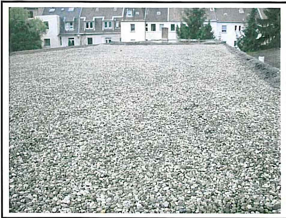
Bild 5: Blick auf Bürodach, Kiesschüttung über Dachpappe und Isolierung
