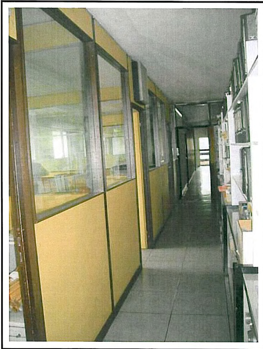
Bild 13: Obergeschoss Bürogebäude, PVC - Bodenbelag
