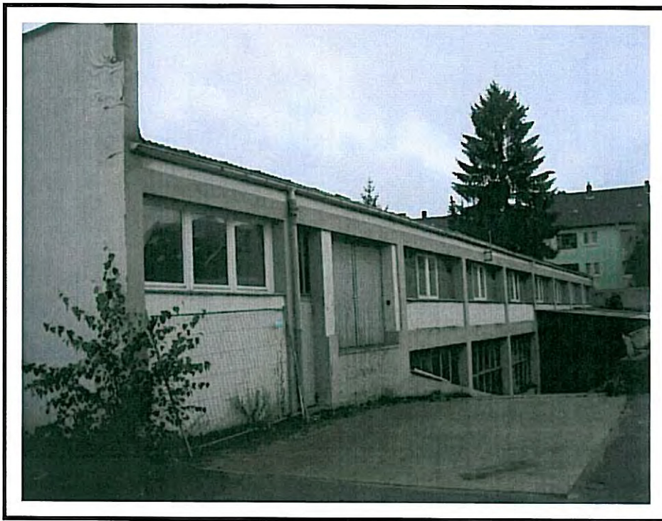
Bild 16: Seitenansicht und Rampe zum Kellergeschoss Halle 2
