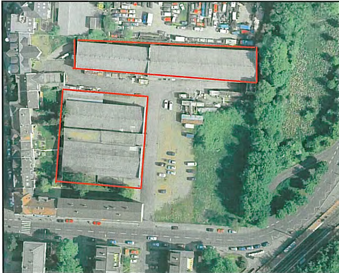
Abb.1: Luftbild zur Lage des Gebäudealtbestandes an der Herler Str. 103 (rot umrandet)
