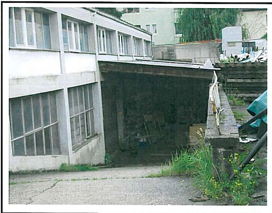
Bild 17: Rampe zum Kellergeschoss der Halle 2
