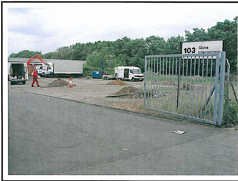
Bild 8: Blick auf die Gesamtbaufäche, Blickrichtung Nordost
