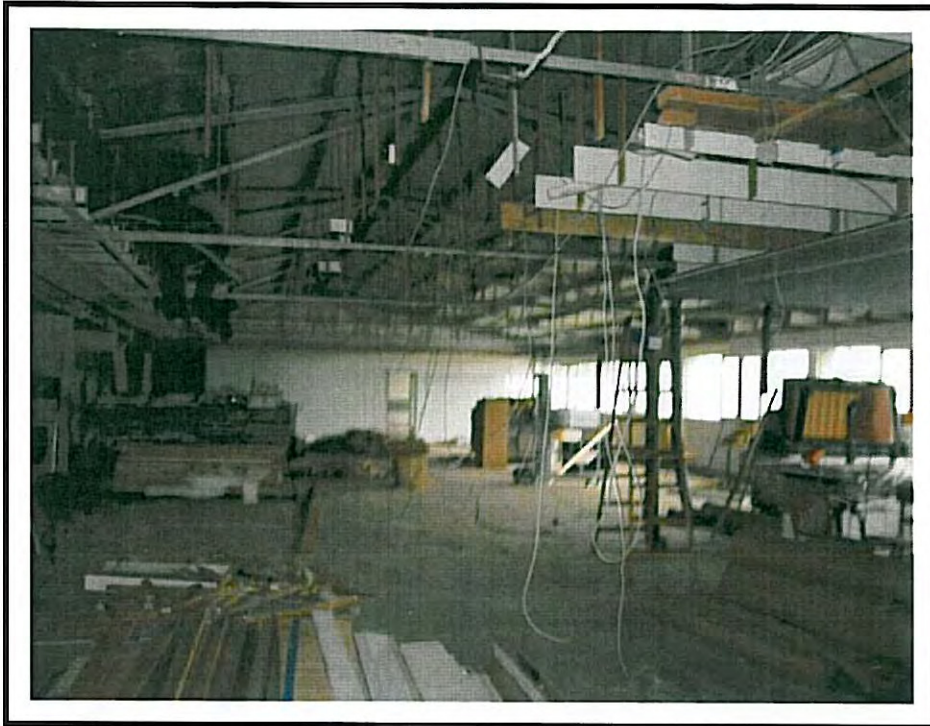
Bild 18: Innenansicht Erdgeschoss Halle 2
