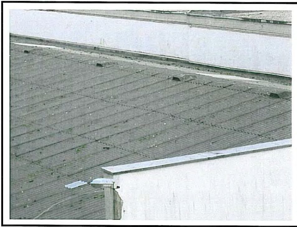
Bild 3: Detail, Halle 1, Welldach
